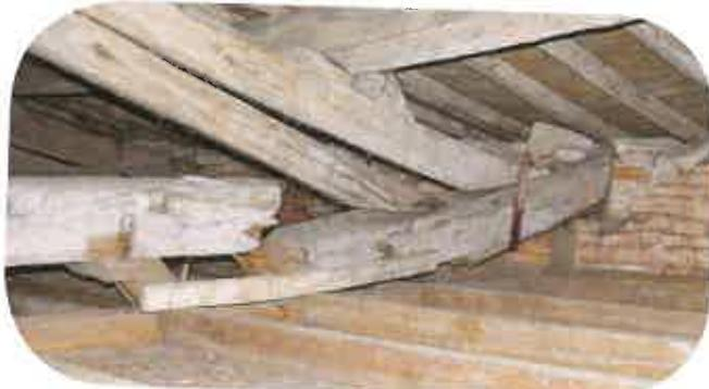
Temple fermé au public: la première ferme de la charpente du temple s'est cassée et provoque une pression sur les murs latéraux. Une partie de la toiture repose directement sur le plafond. Un bureau d'étude travaille sur le dossier pour proposer une réparation.
